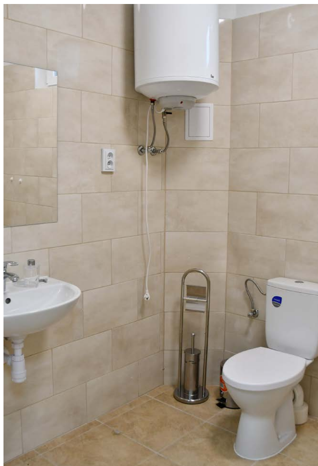
Nowa łazienka w świetlicy wiejskiej w Bojanach
