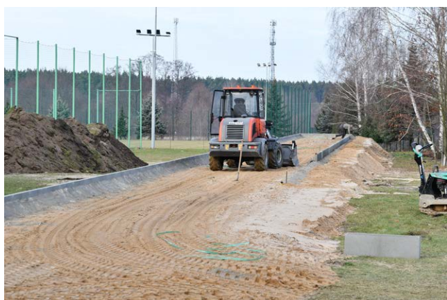
Budowa bieżni lekkoatletycznej
