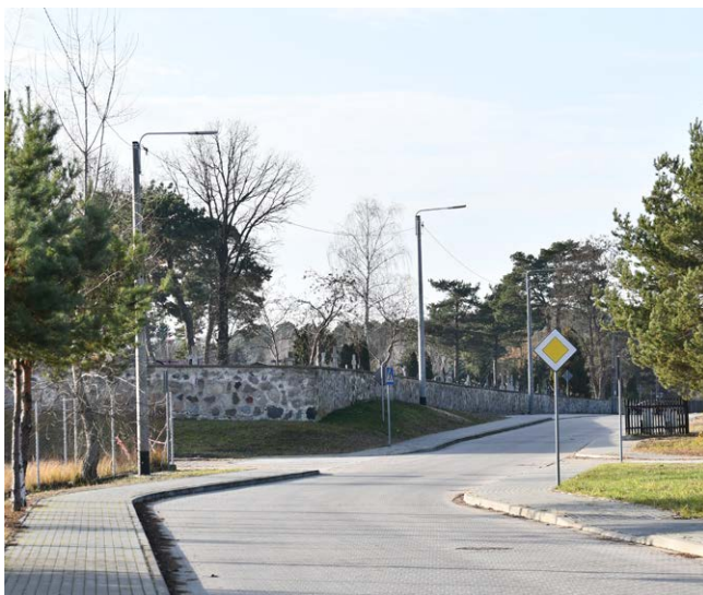
Słupy oświetleniowe na części ul. Sienkiewicza w Broku
