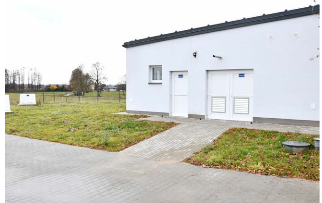
Hydrofornia w Bojanach
