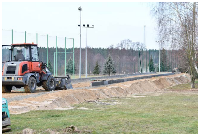
Budowa bieżni lekkoatletycznej
