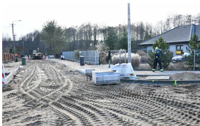
Budowa dróg gminnych na osiedlu „Ludwinowo”
