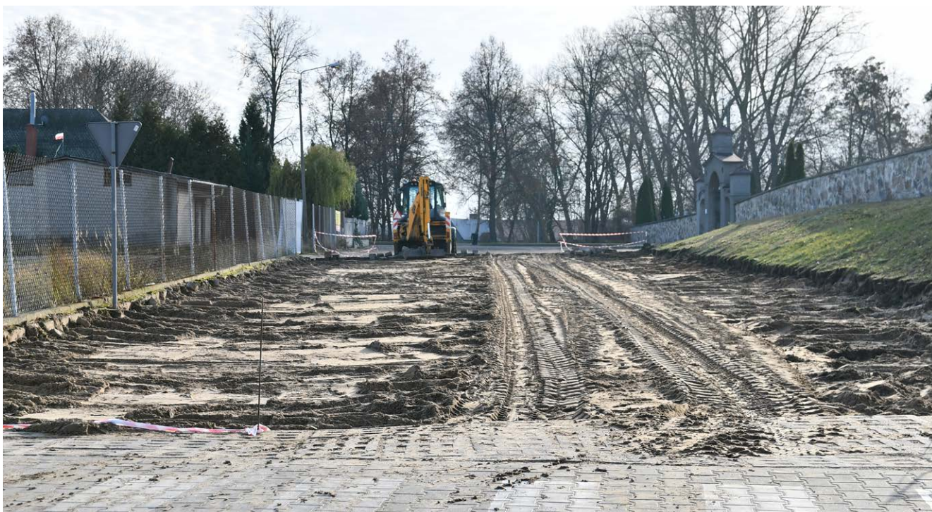
Remonty dróg wykonywane przez pracowników RGK
