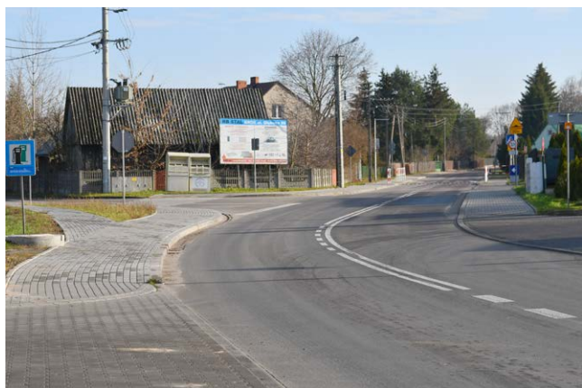
Przebudowane skrzyżowanie dróg gminnych ul. Głębokiej i Jana Pawła II
