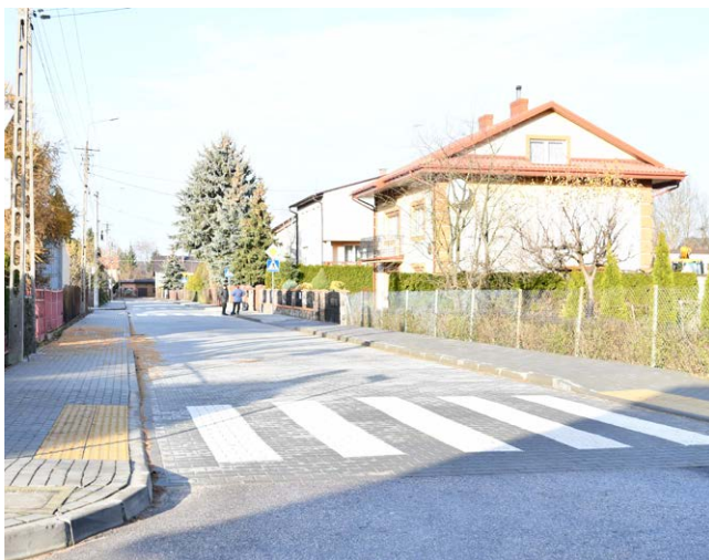
Nowa nawierzchnia i chodniki na ul. Strażackiej, Wyzwolenia, Wójcickiego i Cichej w Broku
