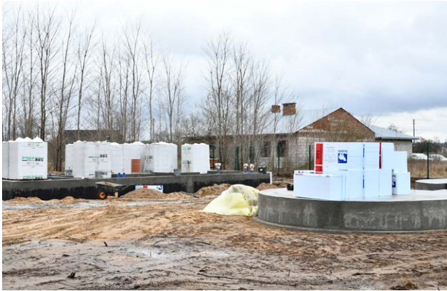
Budowa SUW i wodociągu w Kaczkowie Starym
