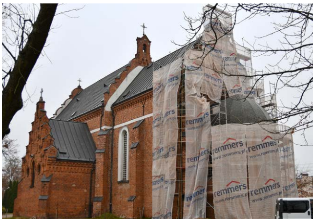
Prace konserwatorskie przy Kościele pw. św. Andrzeja Apostoła w Broku
