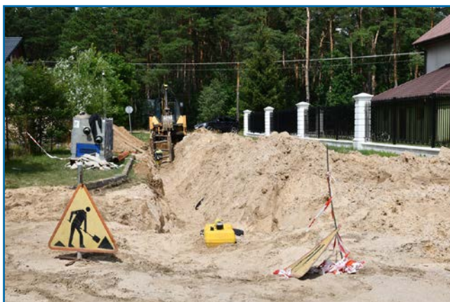
Budowa kanalizacji na osiedlu „Ludwinowo”
