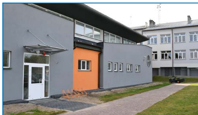
Modernizacja sali sportowej przy Zespole Publicznych Placówek Oświatowych w Broku
