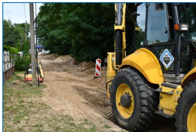
Budowa kanalizacji na ul. Tartacznej
