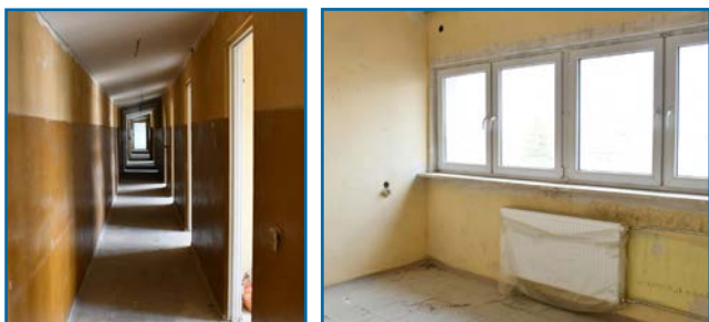
Stan pomieszczeń na II piętrze budynku w Domu Kultury przed remontem
