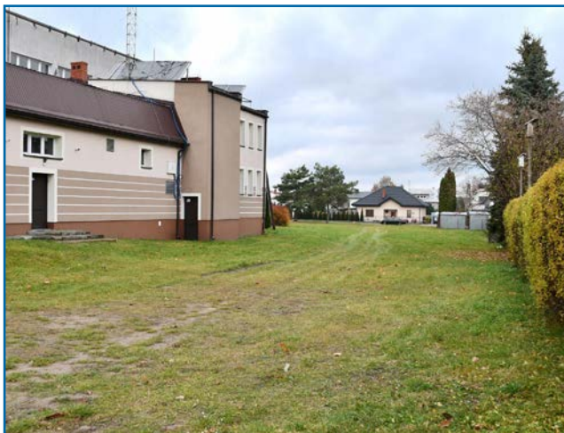
Teren wokół budynku przy ul. Pułtuskiej w Broku przed realizacją inwestycji
