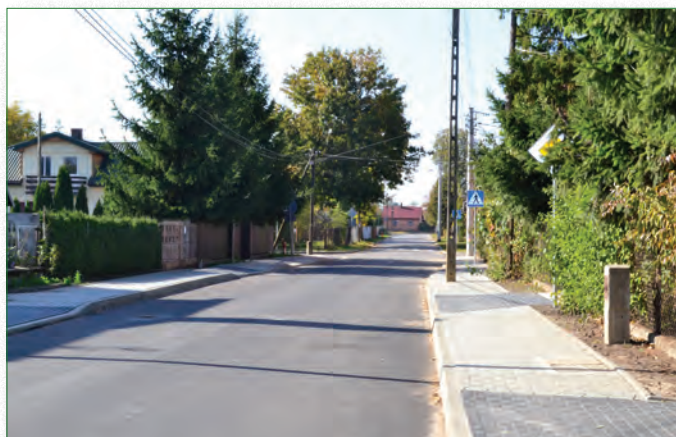
Nowy asfalt na ul. Pułtuskiej
