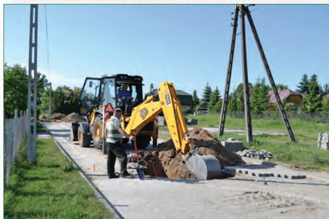
Wykonanie kanalizacji deszczowej przez Referat Gospodarki Komunalnej
