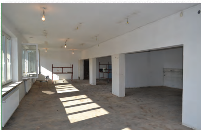
Klub Seniora w trakcie remontu
