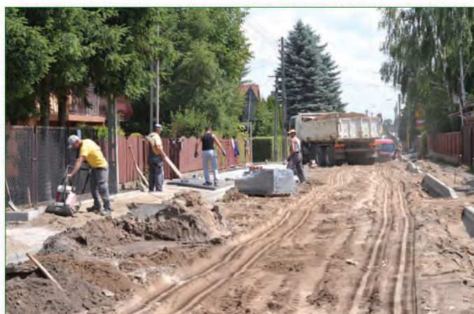
Remont ul. Pułtuskiej
