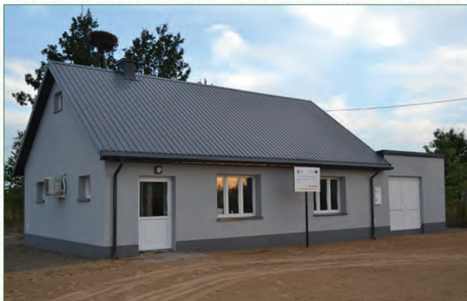
Wyremontowana Świetlica w Sołectwie Czuraj
