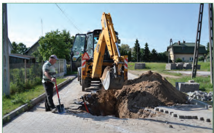
Prace przy budowie sieci kanalizacji deszczowej
