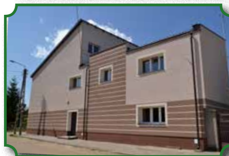
Zrewitalizowany budynek przy ul. Pułtuskiej
